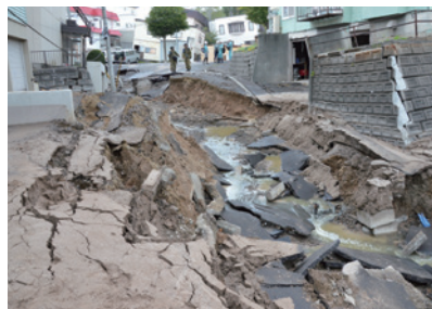
写真1 北海道胆振東部地震による土砂災害(左 厚真町斜面崩壊、右 札幌市里塚液状化)
