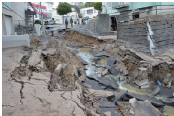
北海道胆振東部地震による液状化現象(札幌市里塚)
