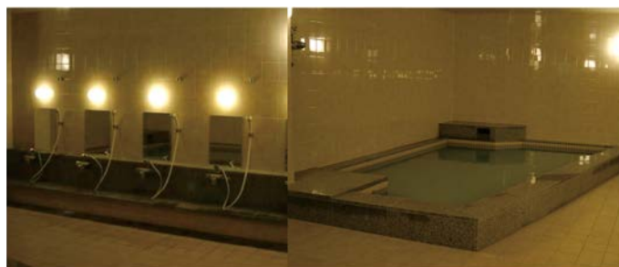
浴 室（管理棟地階） （シャワー室もあり）
