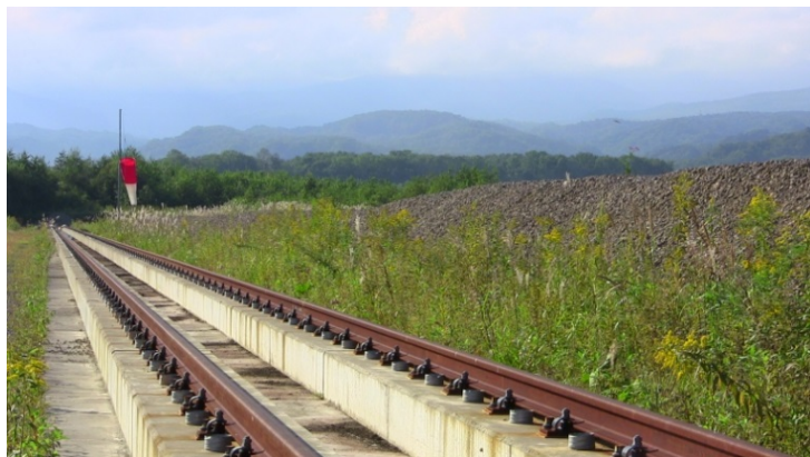
全長300mの走行軌道
