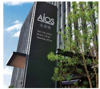
東京事務所建物
