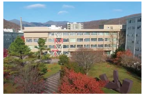
理工学人材育成のための工学基礎教育の拠点となる教育・研究3号館
