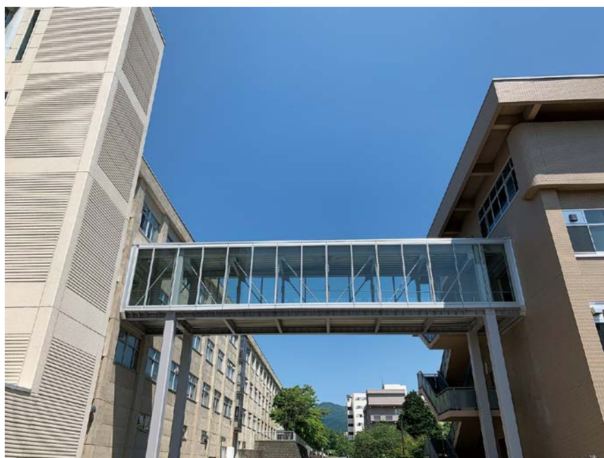
教育・研究1-3号館連絡通路「そらみち」
