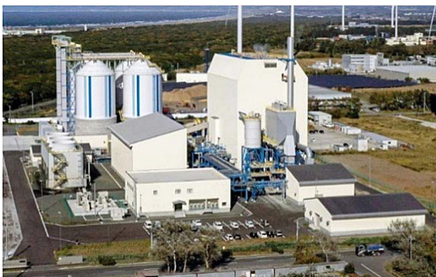
石狩バイオマス発電所
