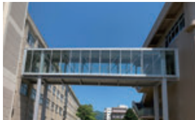
連絡通路「そらみち」 令和2年7月完成
