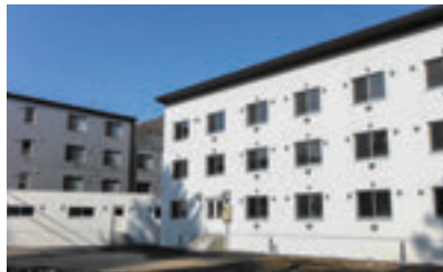
明凜館(女子寮)B棟 平成28年3月完成
